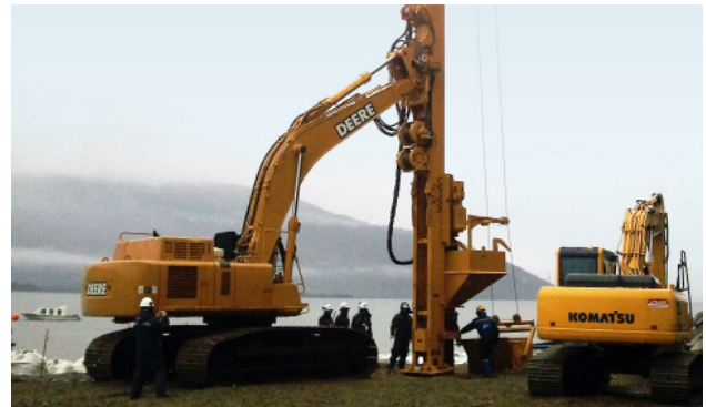
Muelle Mejoramiento Conectividad Maritima Región Aysén, Chile
