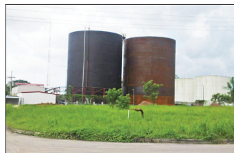
Tanques de Almacenamiento de Aceite Puerto Barrios, Guatemala
