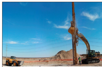
Digester Tank Ciudad Juarez, Chihuahua, México
